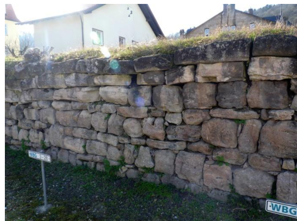
Stadtmauerreste an der Burggasse (Quelle: RoosGrün)
